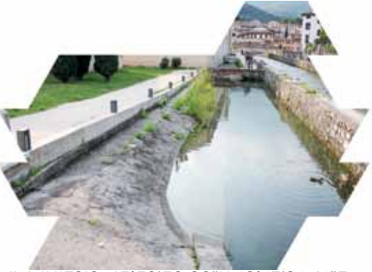
01_IL LAVATOIO_ 45°59'50.08"N 12°17'31.41"E
