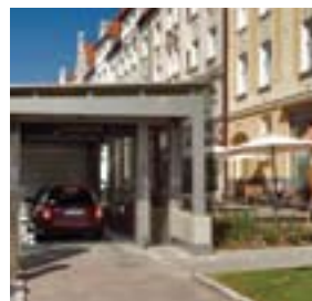
La porta si apre automaticamente ed il conducente viene guidato da delle istruzioni riportate su un display testuale.
