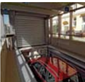
L'auto viene portata al livello -1 attraverso un ascensore verticale.
