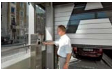
L'utente conferma la procedura di parcheggio al pannello di comando, la porta si chiude e gli scanner laser al soffitto nell'area di entrata controllano la posizione corretta della vettura.
