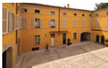
Edificio dopo la ristrutturazione.
