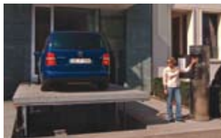
Il funzionamento del sistema è semplice: l'utente lo manovra inserendo una chiave specifica e premendo il tasto di salita fino a che il posto auto non raggiunge la posizione sollevata.
