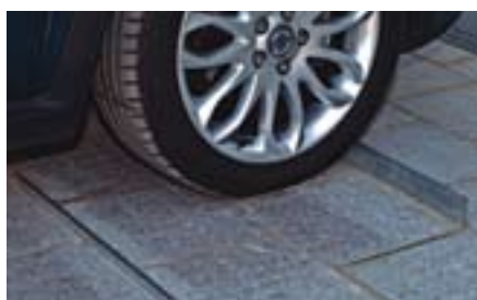
Il fermaruote per il posto auto sopra la copertura dell'impianto, fissato ed integrato nel pavimento in pietra, è efficace e ben progettato.
