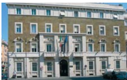
Facciata dell'edificio in pietra sperone e travertino dalle linee semplici ma con riquadrature decorative alle finestre sulle quali spiccano teste di fanti ed aquile.
