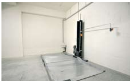
Vista interna di un box auto in cui è installato un impianto IP1-ML con piattaforma abbassata. La colonna può essere realizzata a scelta sia a destra che a sinistra. L'altezza sotto il pianale è regolabile da 155 cm a 200 cm per parcheggiare qualsiasi tipologia di auto.
