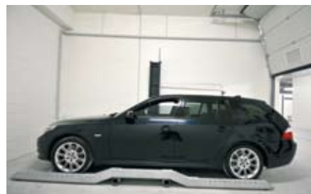
Parcheggio dell'auto sulla piattaforma. L'impianto solleva auto fino ad un massimo di 2.500 kg di peso. Le misure in lunghezza e larghezza del pianale sono modificabili per permettere il parcheggio anche di motociclette.
