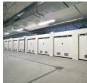
Vista interna dell'autorimessa dove si trovano box auto di diverse dimensioni completi di serranda avvolgibile motorizzata.
