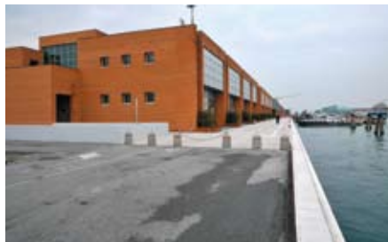
Vista dell'edificio direzionale direttamente affacciato sul mare e sotto il quale sorgono 100 box auto.
