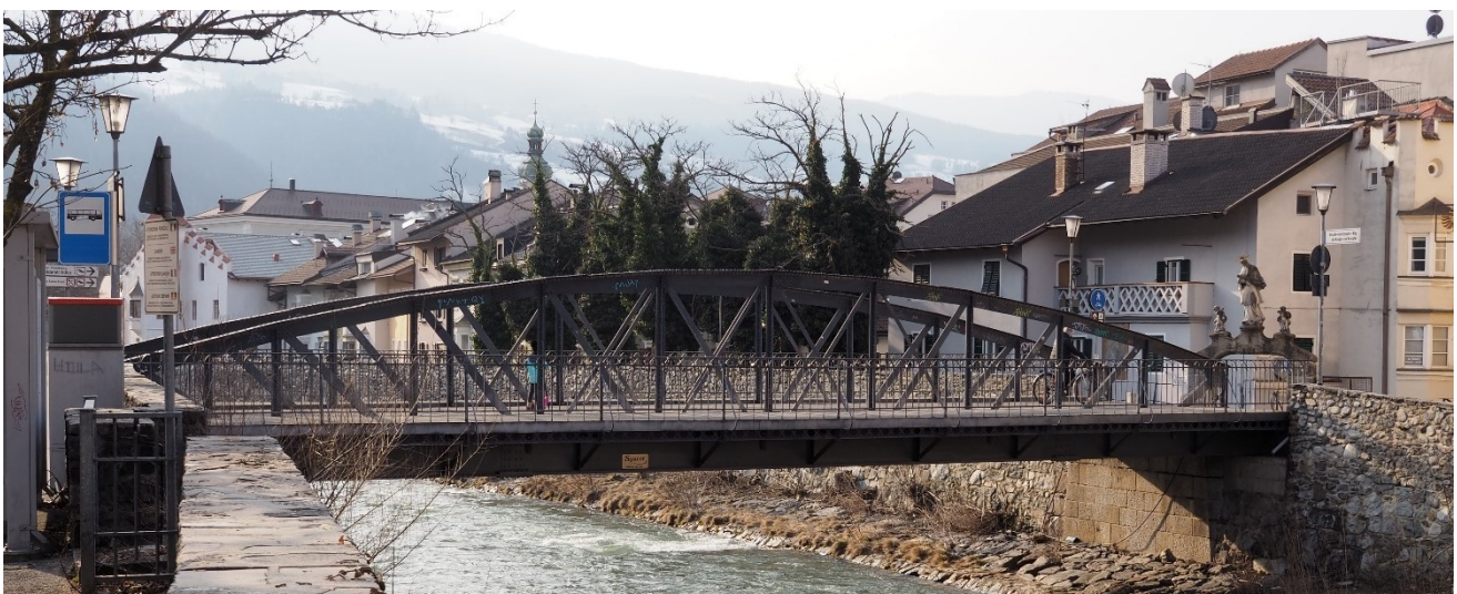
Adlerbrücke, Blick von Norden Osten Ponte Aquila, veduta da nord
