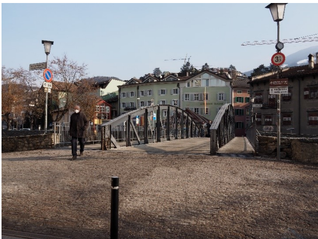
Adlerbrücke – Blick Richtung Osten Ponte Aquila – vista verso est
