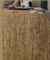
rivestimento in hempwood
